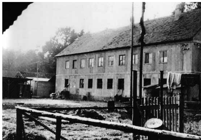
Fabrikgelände mitten im Wald
